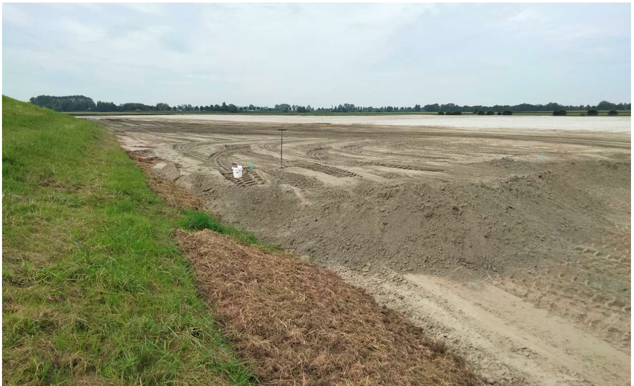
Foto 2: uitgezette partij 8 tweede laag zand van 1 m dik tegen de Zeedijk
